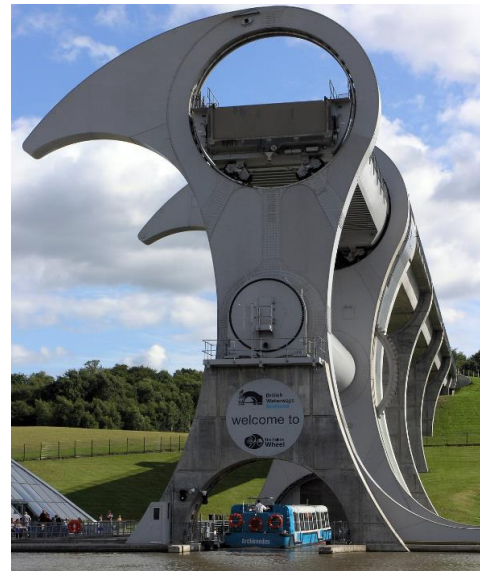
Photo de l'écluse
