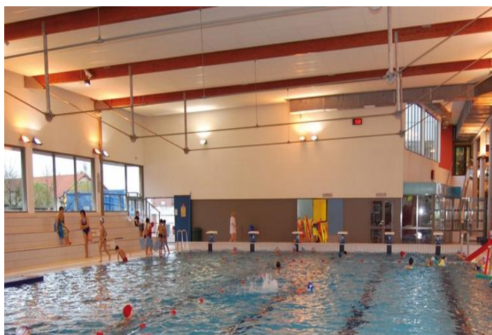
Charpente du grand bassin de la piscine
