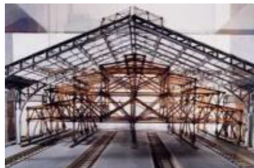
Structure métallique de la gare de Santiago du Chili, fabriquée au Creusot
