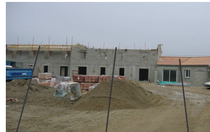
Mise en place de la charpente industrielle (fermettes).
