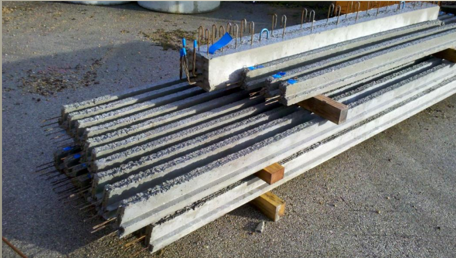
Poutre rectangulaire et poutrelle en T
